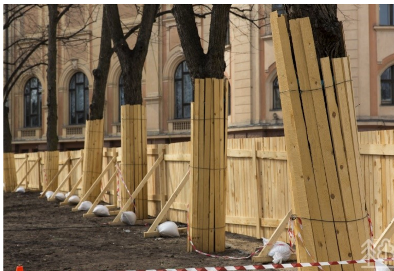
2.attēls. Piemērs koku aizsardzībai būvdarbu laikā
